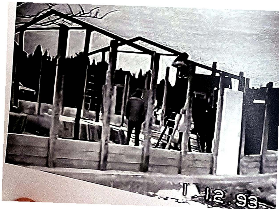
Foto: Adam Grauer. Der Rohbau nimmt Gestalt an, 01.12.1993.
