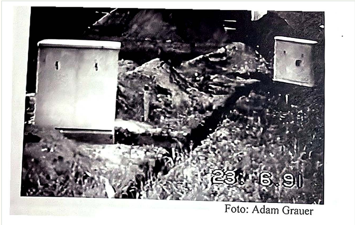
Foto: Adam Grauer. Die Stromkabel liegen bereits.
