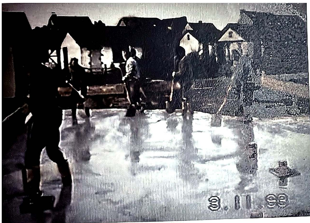
Foto aus der Chronik, datiert 03.11.1993: Die Bodenplatte des Vereinsheims ist gegossen.
